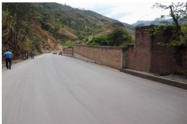
Pavimentación en asfalto - Sector La Cruz
