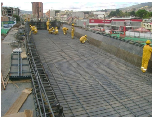
INSTALACIÓN ACERO DE REFUERZO EN VIGA LATERAL Y PISO TRAMO 9-8
