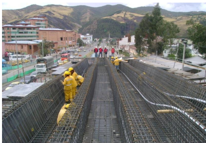
INSTALACIÓN ACERO DE FUERZO Y DUCTOS PARA CABLE DE PRETENCIONAMIENTO VIGAS SECCIÓN 9-8
