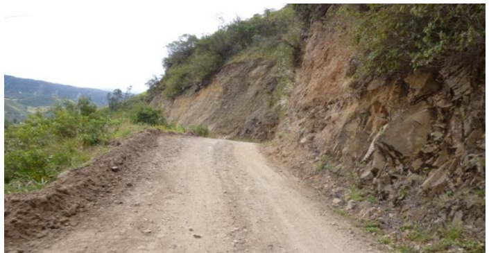
KM 1+500 vía Puerres – San Mateo, vista luego de la conformación del material
