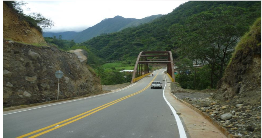
Foto: km28+120 Circunvalar Galeras, Puente Sobre Rio Azufra
